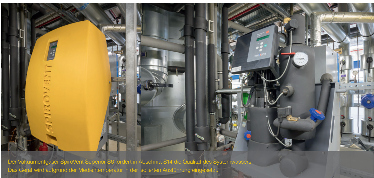
Durch den kompakten Aufbau der SpiroPress MultiControl Cool und den voll nutzbaren Inhalt des Expansionsgefäßes ist die Anlage selbst gut zugänglich.
