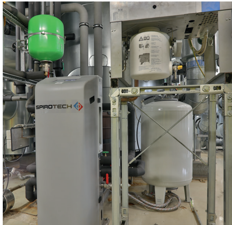
Durch den kompakten Aufbau der SpiroPress MultiControl Cool und den voll nutzbaren Inhalt des Expansionsgefäßes ist die Anlage selbst gut zugänglich.
