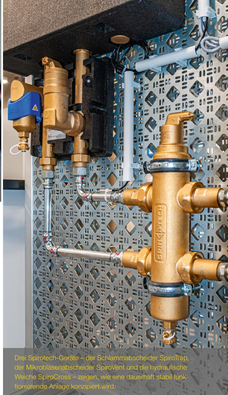
Drei Spirotech-Geräte – der Schlammabscheider SpiroTrap, der Mikroblasenabscheider SpiroVent und die hydraulische Weiche SpiroCross – zeigen, wie eine dauerhaft stabil funktionierende Anlage konzipiert wird.
